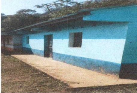
Foto1: Ampliación, construcción de corredor del aula, cambio de puerta y colocación de baranda.
