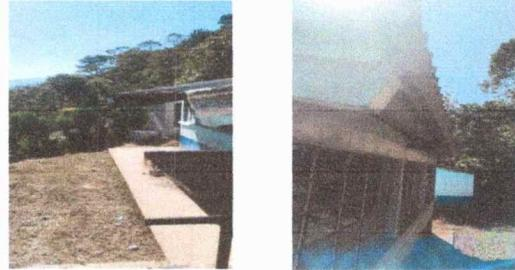
Foto 2: Fabricacion y colocacion de canales
